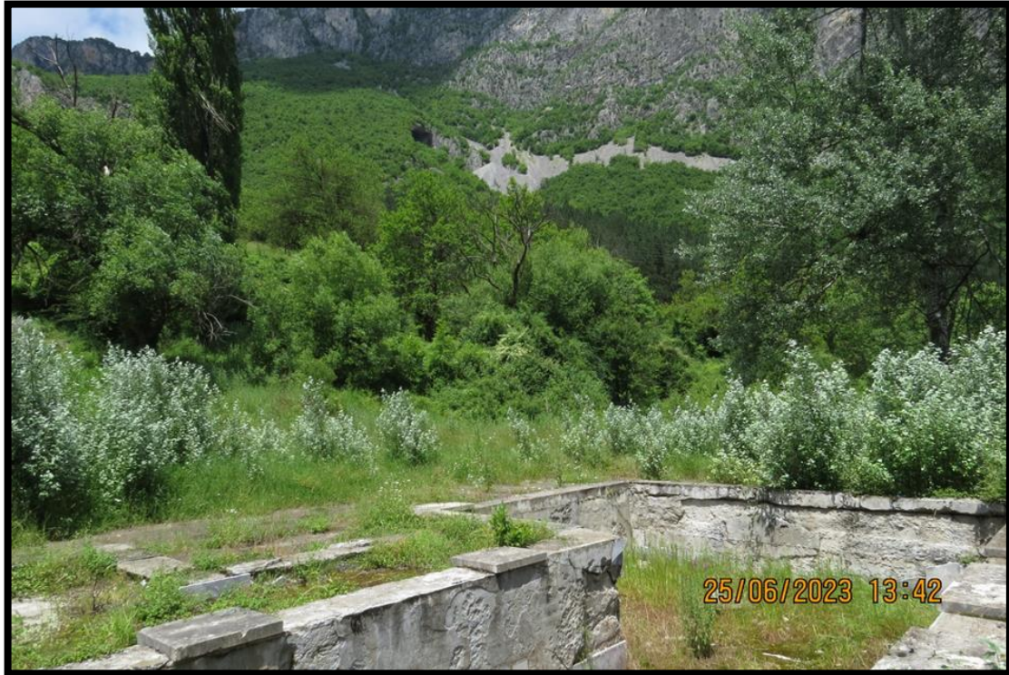
Снимка 3 Изоставени антропогенни структури в ПИ № 009053 и изглед към централната част на територията на ИП
