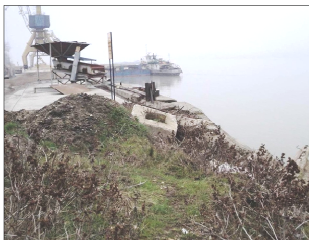
Фиг. 3.6.-5 – Изглед на имот XI, северозападна граница с р. Дунав – бетонни остатъци, продължение на съществуваща кейова стена към пристанище Оряхово
