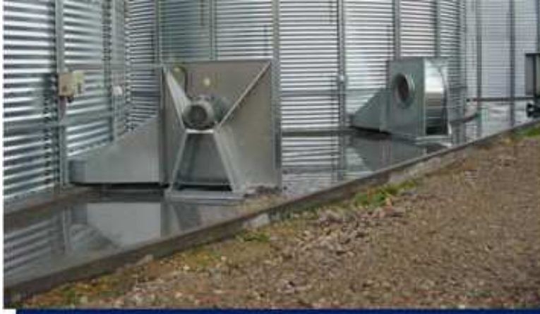
Фиг. 1.6.3. – 5. Вентилационна система към силози
