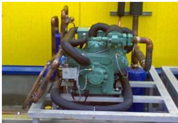
Компресор на хладилна инсталация
